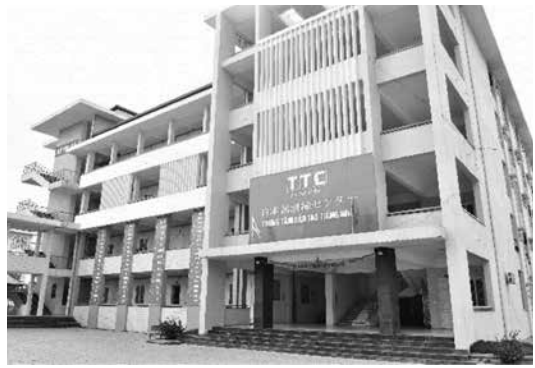
送り出し機関の日本語教育施設の外観
